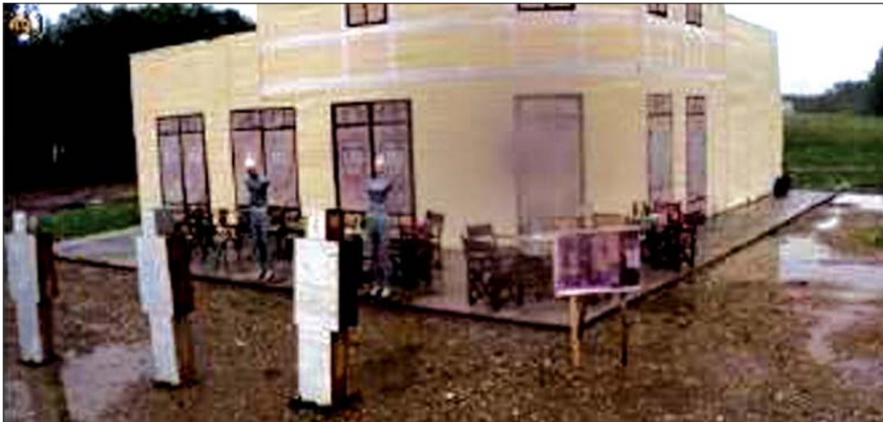
Изглед објекта кафеа „Капија“ након опита 2016. НЕМА ОШТЕЋЕЊА НА ОБЈЕКТУ И БАШТИ КАФЕА „КАПИЈА“.
